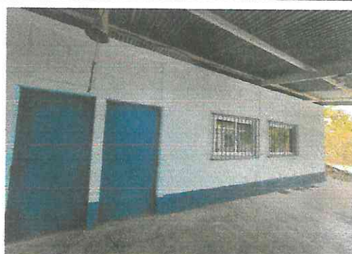
Foto 4: Se finaliza la pintura de los muros e instalación de ventanas de PVC con vidrio en el lado exterior del aula.
