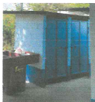
Foto 10: se finaliza el lijado, pulido y pintura de las puertas de los baños así como la pintura de los muros exteriores.
