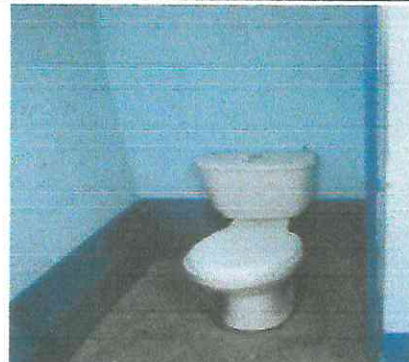
Foto 8: Se finaliza la sustitución del sanitario 1 así como la pintura de los muros interiores.
