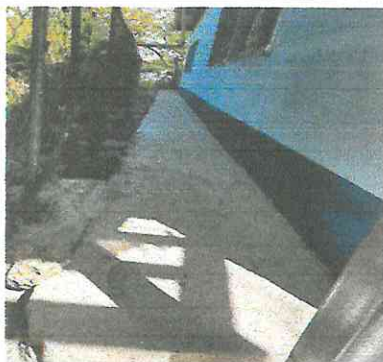
Foto 7: Se finaliza la instalación de la banqueta de concreto alrededor de las aulas 1 y 2.
