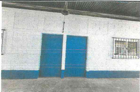
Foto 1: Se finaliza el lijado, pulido, pintado de las puertas, refuerzo de los marcos e instalación de chapas en las aulas 1 y 2.
