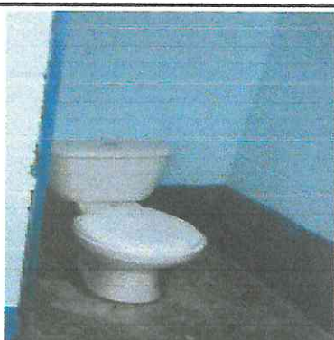
Foto 9: Se finaliza la sustitución del sanitario 2, así como la pintura de los muros interiores.
