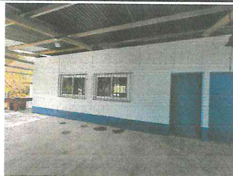
Foto 2: Aula 1: Se finaliza la pintura de los muros interiores y exteriores e instalación de ventanas de PVC con vidrio y del sistema eléctrico.
