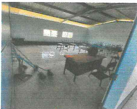
Foto 5: Aula 2: Se finaliza la aplicación de repello, pintura de muros, sustitución del piso de cemento por cerámico, instalación de ventanas de PVC con vidrio y del sistema eléctrico.
