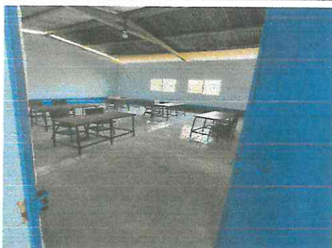
Foto 3: Se aplica repello y pintan los muros interiores del aula 1, se sustituye el piso de cemento por cerámico, se instalan ventanas de PVC Más vidrio, y se instala el sistema eléctrico.
